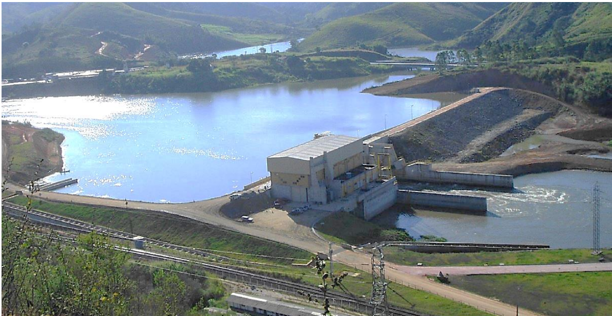
Figura 1. Barragem Queluz. Fonte: Fractal Engenharia (QLZ_SB_01MAR).
