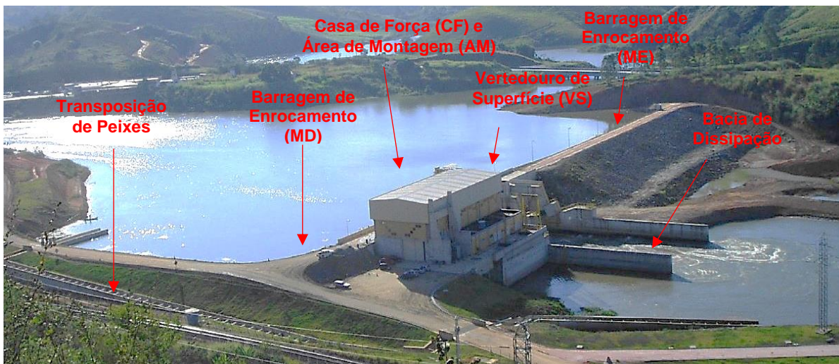
Figura 4. Conformação do Barramento da PCH Queluz.
